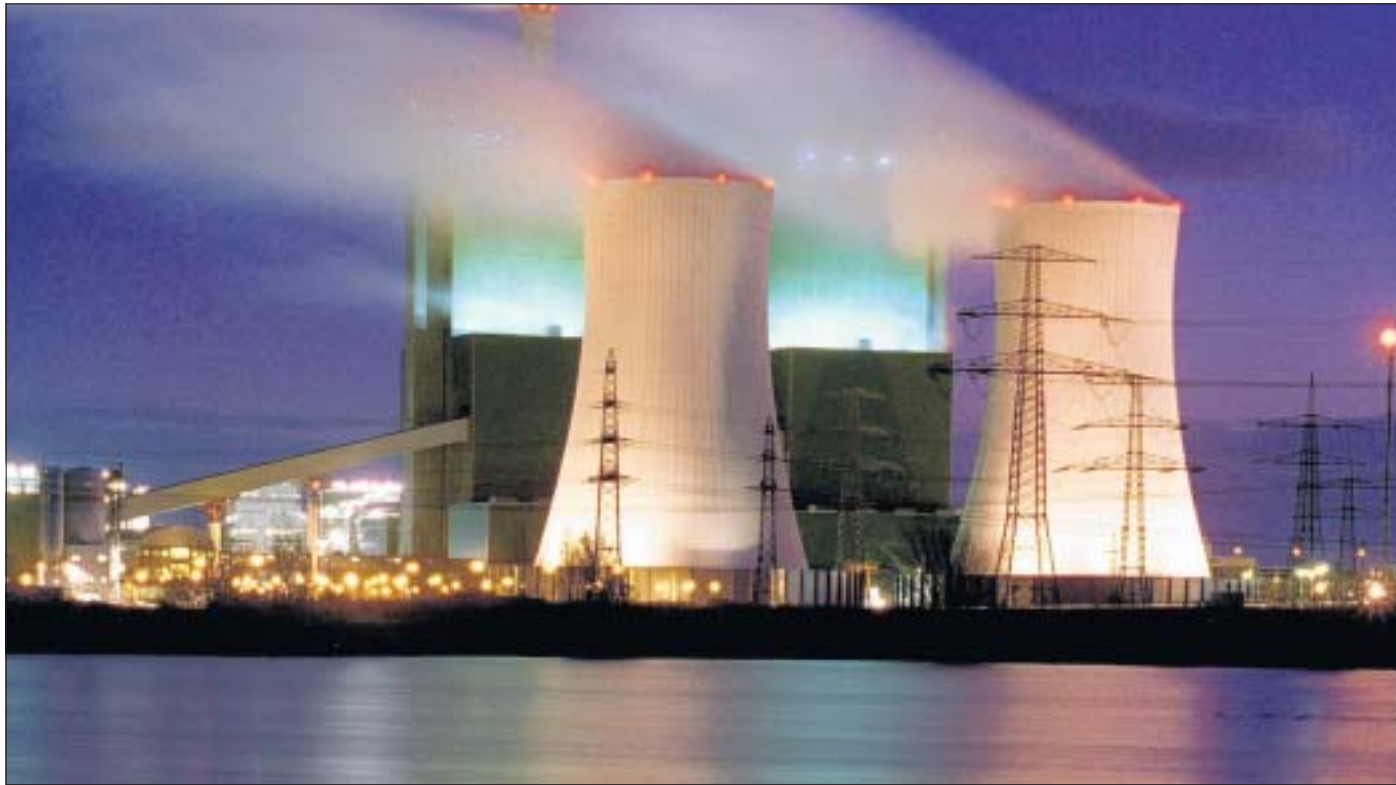
Das Braunkohlekraftwerk Schkopau südlich von Halle. Es gehört zu den Hauptstromfabriken in Mitteldeutschland.
