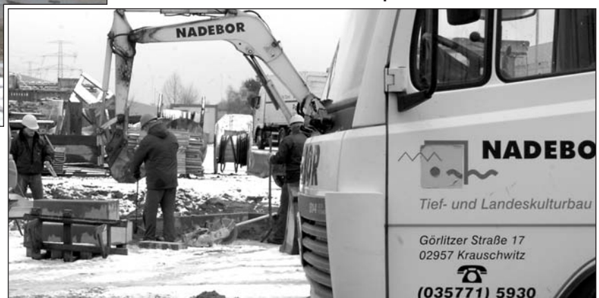
Überall auf der Baustelle sind Firmenfahrzeuge aus der Region zu sehen. Über 60 Prozent der Firmen zeigen uns bekannte Nummernschilder. Zu den Stoßzeiten arbeiteten hier über 300 Menschen gleichzeitig - eine logistische Meisterleistung der Bauleitung
